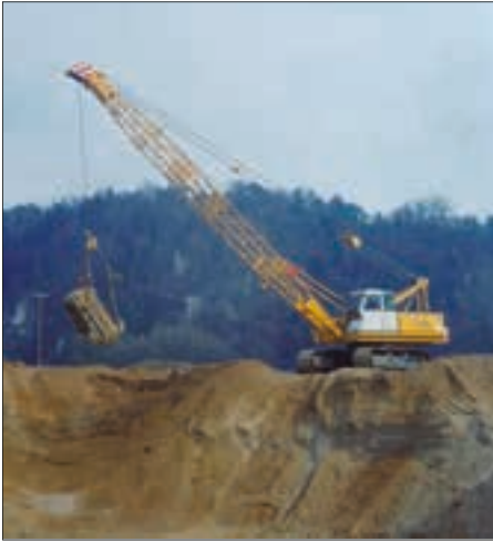
1969: Erster vollhydraulischer Seilbagger weltweit, SK 15
