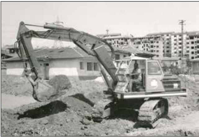
1976: S 517 mit Raupenfahrwerk und Kunststoffkabine im Erdbau
