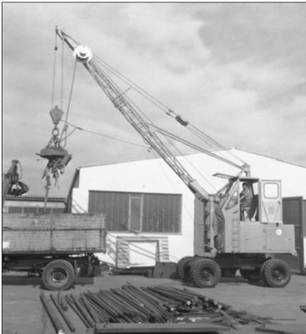
1962: Seilbetriebener S833 mit erhöhter Fahrerkabine
